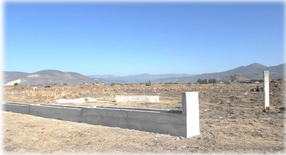
Mera Rehabilitasyon Çalışmaları Sanat Yapıları (Milas İlçesi, Kuru Mahallesi)
