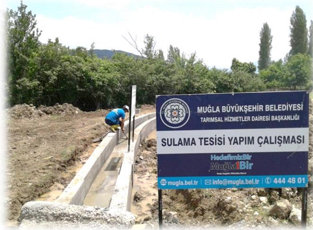
Sulama Tesis Yapım Çalışması (Seydikemer İlçesi, Çatak Mahallesi)
