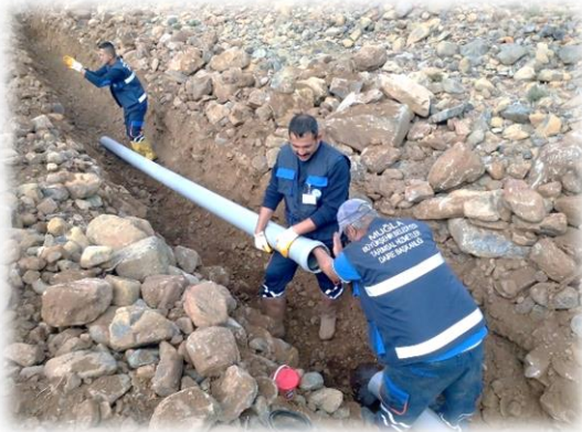
Sulama Suyu Boru Hattı Döşenmesi (Köyceğiz İlçesi, Balcılar Mahallesi)
